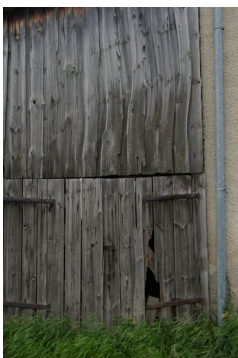
Holzverschalungen an Nebengebäuden
