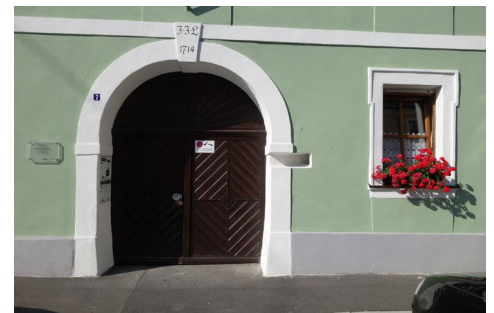
Fassadenansichten mit variantenreichen Details
