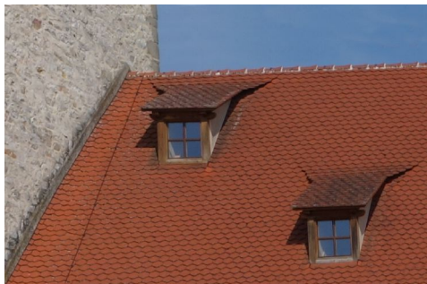
Beispiel: Schleppgauben auf der Burg Dagestein
