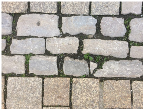
Natursteinpflaster, teilweise in Wiederverwendung
