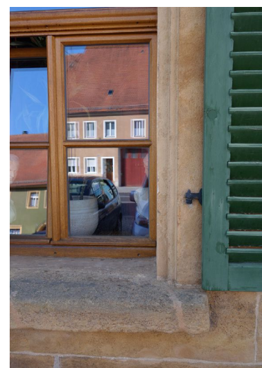
Holzfenster in der Sandsteinfassade
