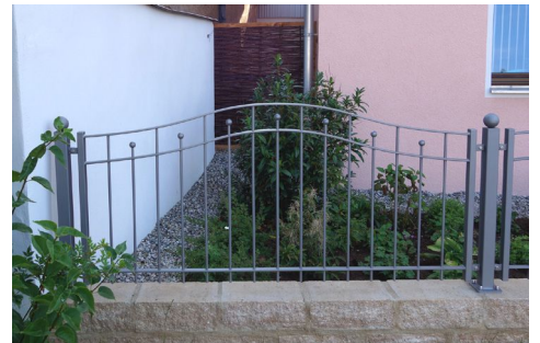
Neuer handwerklich gefertigter Metallzaun am Altstadtrand
