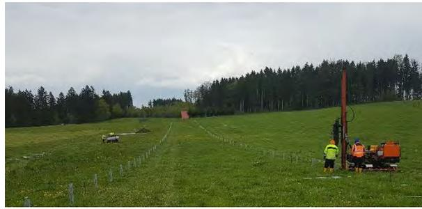
Abbildung 1: Hydraulikramme auf Ketten
