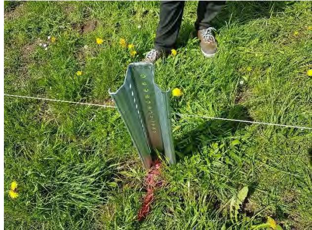
Abbildung 4: Rammfundament
